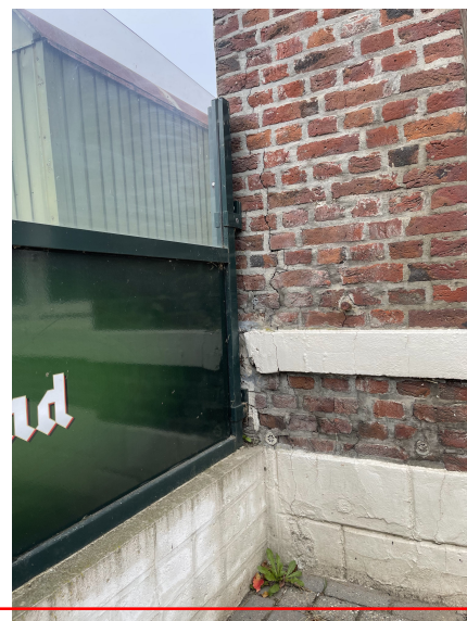
scheurvorming metselwerk
