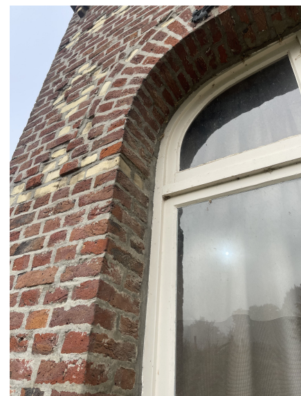
weggesleten mergel door hogedrukreiniging
