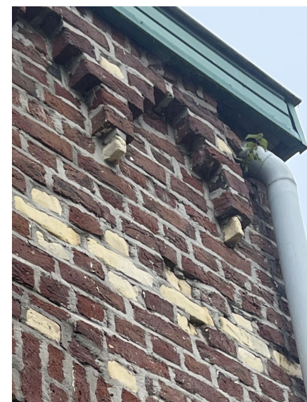
metselwerk weggekapt tbv hwa
