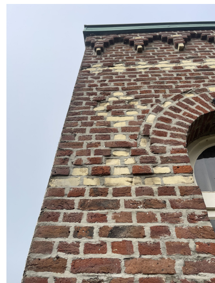
weggesleten mergel door hogedrukreiniging
